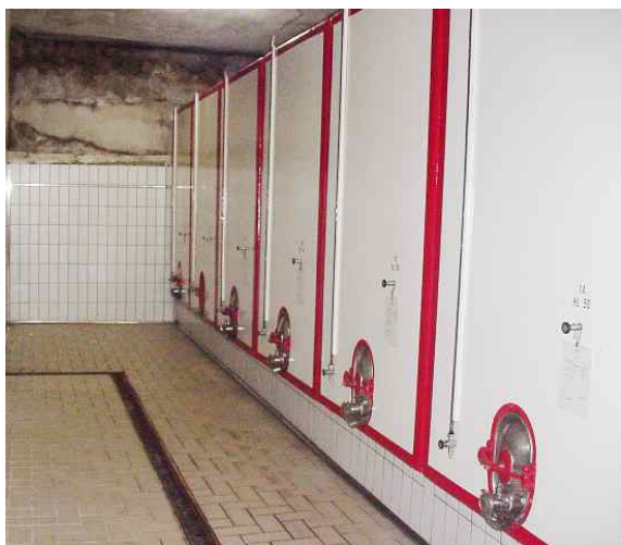
Vasche di cemento per la fermentazione dei vini
