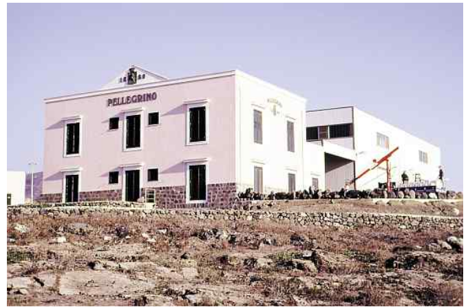
Cantina di Pantelleria in contrada Kuddie Rosse
